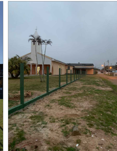
ÁREA LATERAL - FUTURO ESTACIONAMENTO
