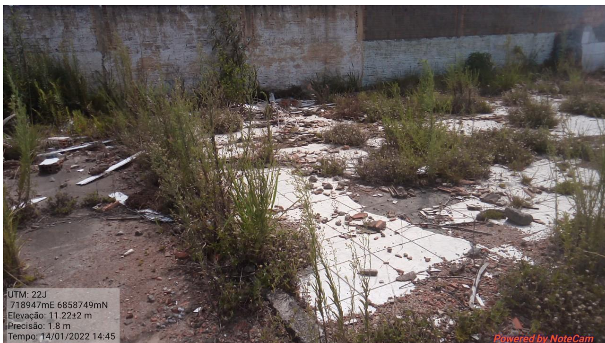
Figura 10: Vista parcial do imóvel vistoriado, notar restos de construção parcialmente demolida. Fonte: autor, 2022.
