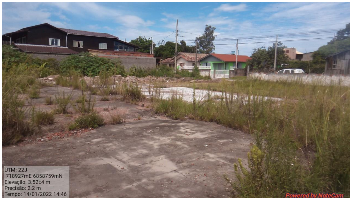
Figura 13: Vista parcial do imóvel vistoriado, notar restos de construção parcialmente demolida. Fonte: autor, 2022.
