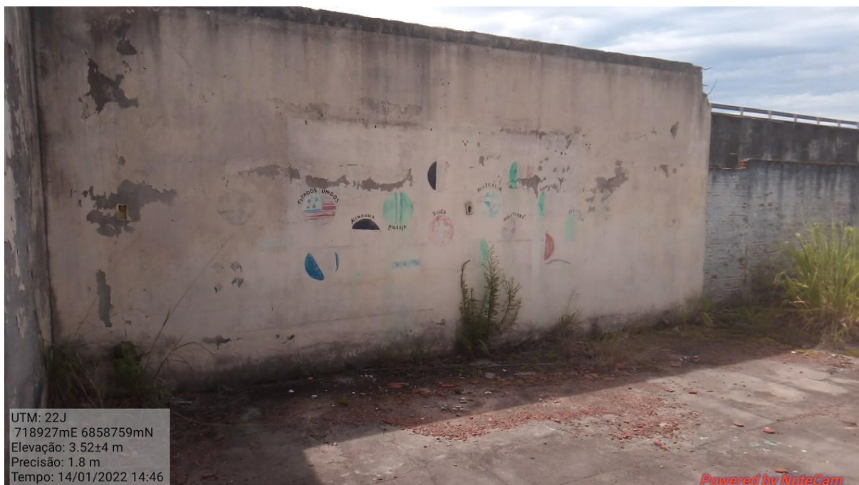
Figura 14: Vista parcial do imóvel vistoriado. Fonte: autor, 2022.
