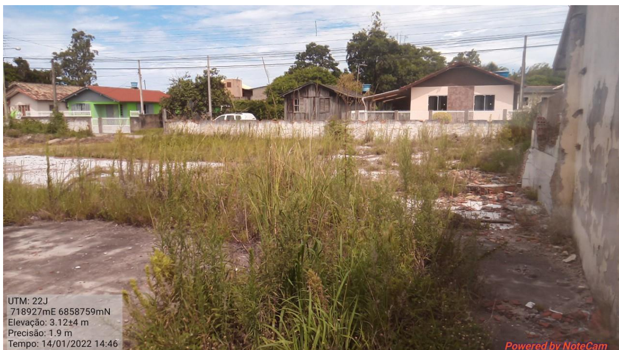
Figura 12: Vista parcial do imóvel vistoriado, notar restos de construção parcialmente demolida. Fonte: autor, 2022.
