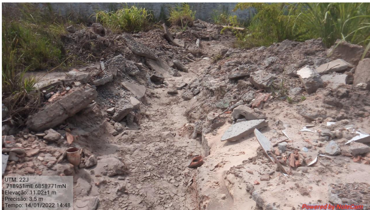
Figura 17: Vista de valeta escavada dentro do imóvel vistoriado. Fonte: autor, 2022.
