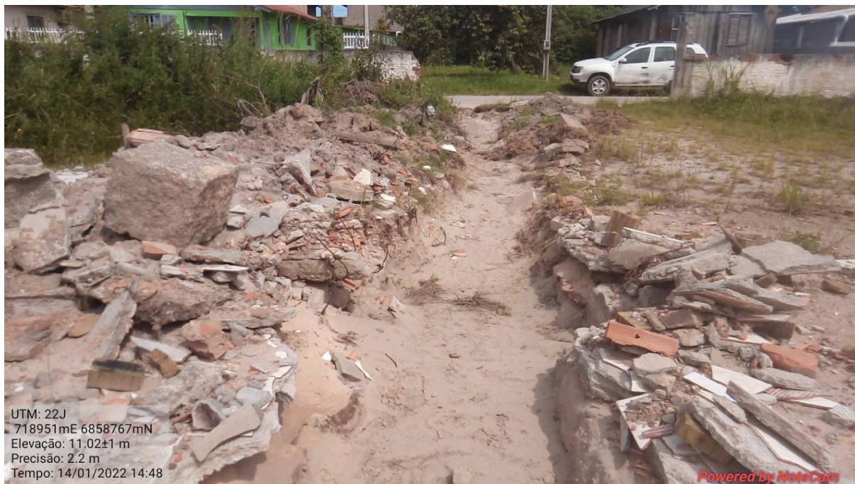
Figura 18: Vista de valeta escavada dentro do imóvel vistoriado. Fonte: autor, 2022.
