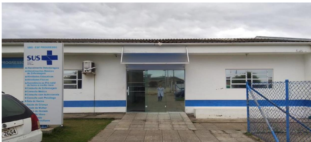
Figura 18 - Estrutura física da ESF Progresso do Município de Laguna/SC.
