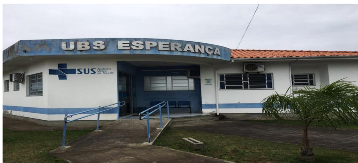
Figura 12 - Estrutura física da ESF Esperança do Município de Laguna/SC.
