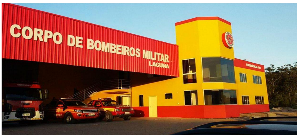
Figura 28 - Estrutura física do CBM do Município de Laguna/SC.
