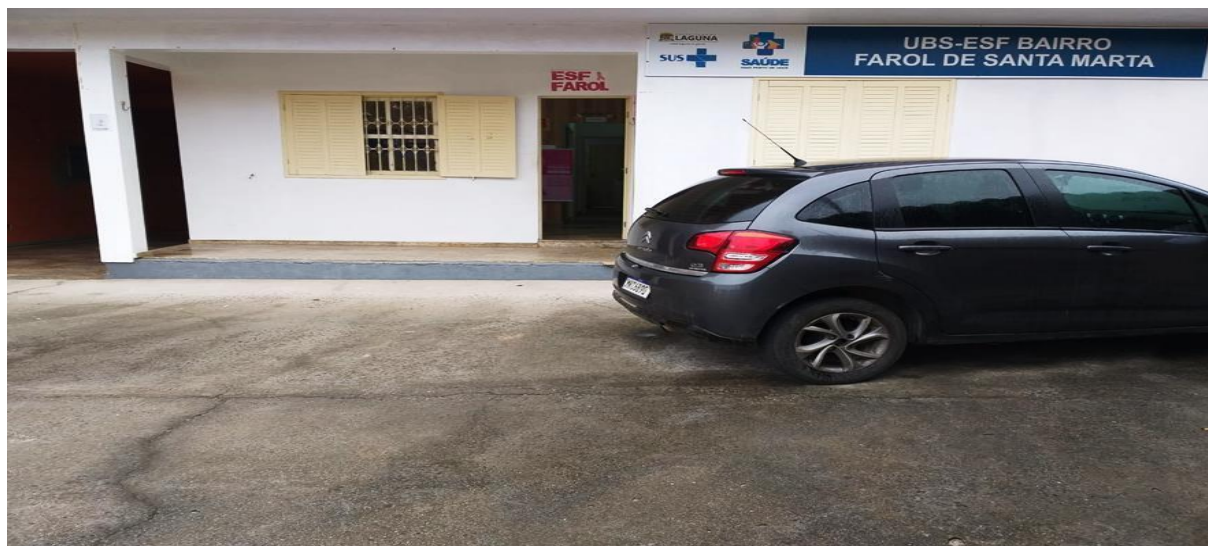
Figura 13 - Estrutura física da ESF Farol do Município de Laguna/SC.
